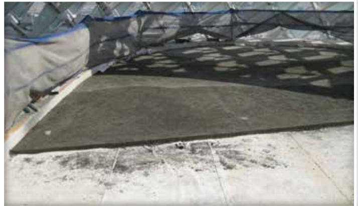
CHAPE ISOLANTE SUR TOITURE-TERRASSE - Formule 800 Kg/m 3
